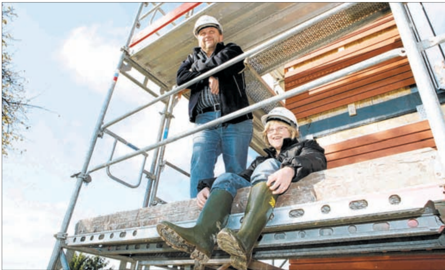
Bauführer Robert Loosli zeigt der Tochter seinen Arbeitsplatz: die Baustelle. BILD MANUELA JANS
